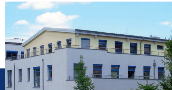
IB Bildungszentrum Asperg Leistung: 70,08 kWp, CO 2 -Einsparung: jährlich ca. 32 t
